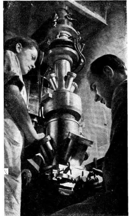
Bild 5. Übermikroskop von Siemens & Halske (ältere Bauart).
